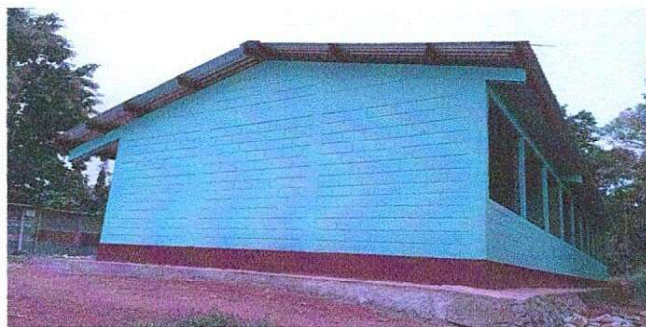
Foto1: Entechado totalmente instalados.
