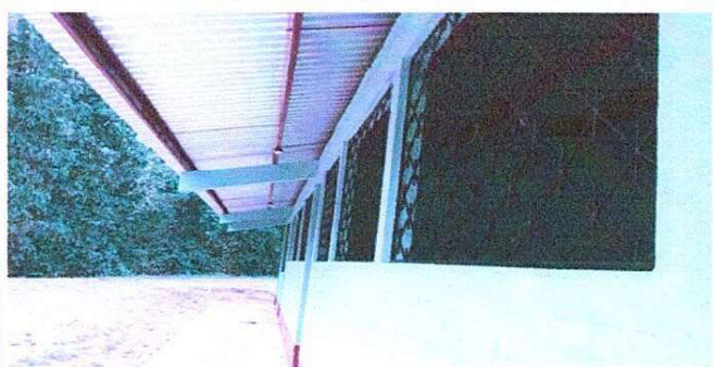
Foto 3: balcones totalmente remozadas.
