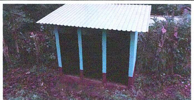
Foto 5: Baños totalmente remozadas.
