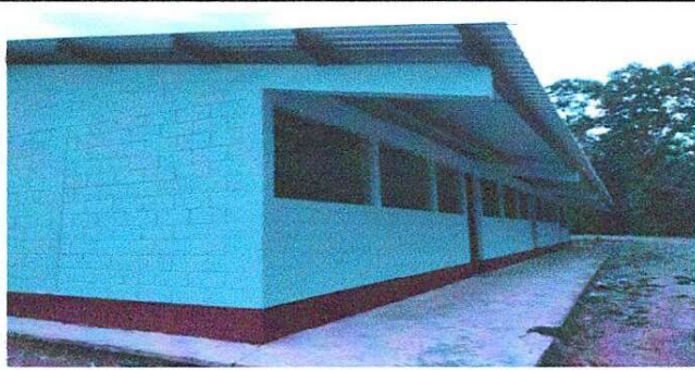
Foto 6: Estructura metalica totalmente remozada y tambien se puede observar un nuevo ambiente (pintura).
