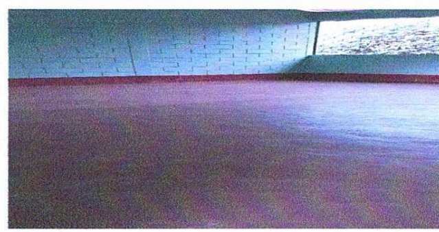
Foto 4. Torta o Piso totalmente terminada.
